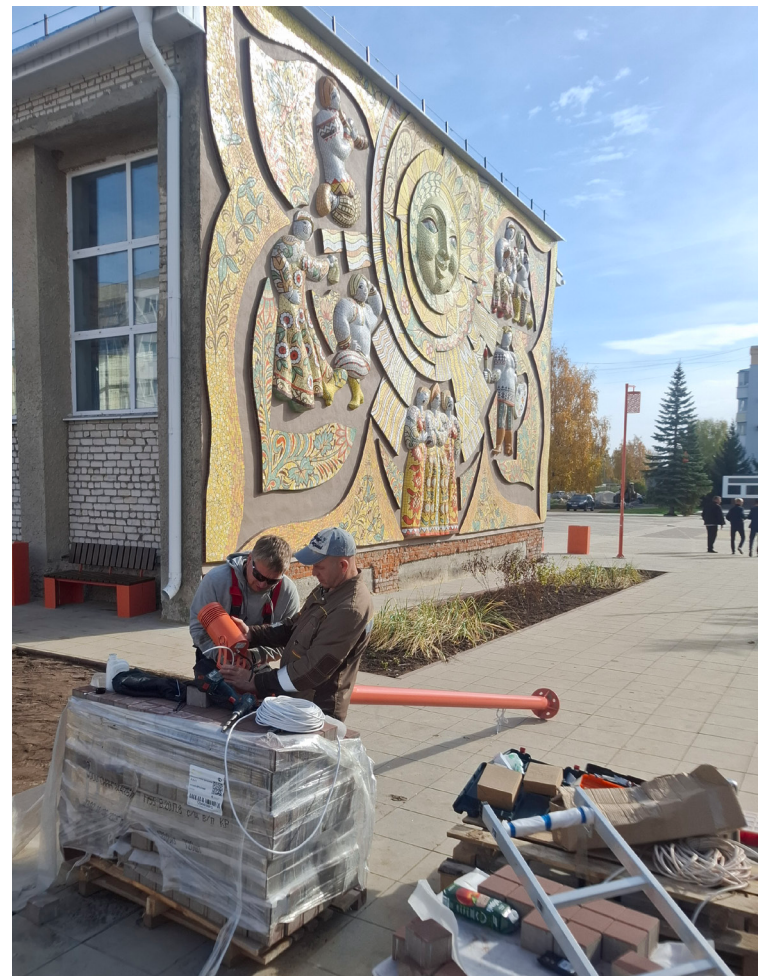
Рядом с восстановленным панно устанавливаются новые светильники
